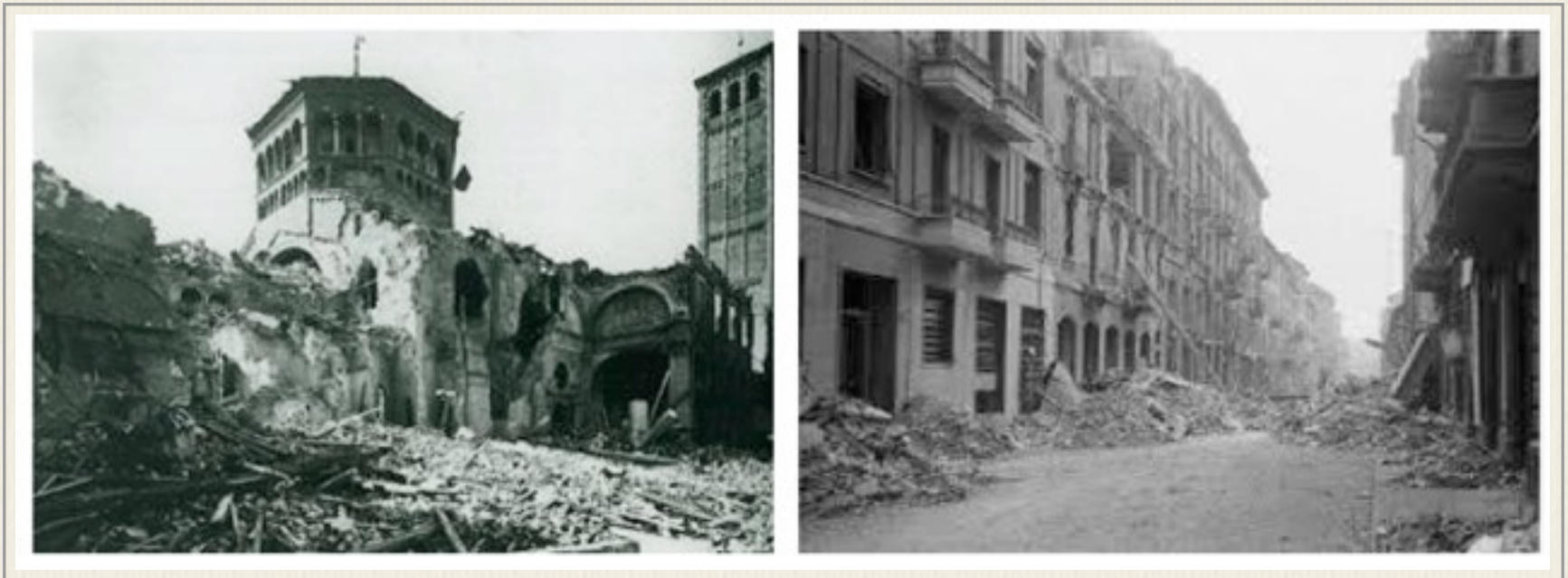
Due immagini emblematiche della distruzione della guerra: a sinistra La chiesa di Sant' Ambrogio e una strada nel centro di Milano dopo il devastante bombardamento del 7 e 8 agosto del 1943
