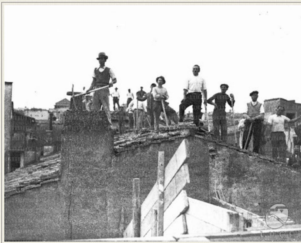
La percezione di una concreta formazione e dei pericoli relativi al lavoro è stata per molti anni sottovalutata. Qui un gruppo di muratori sta demolendo una casa senza alcuna protezione.
